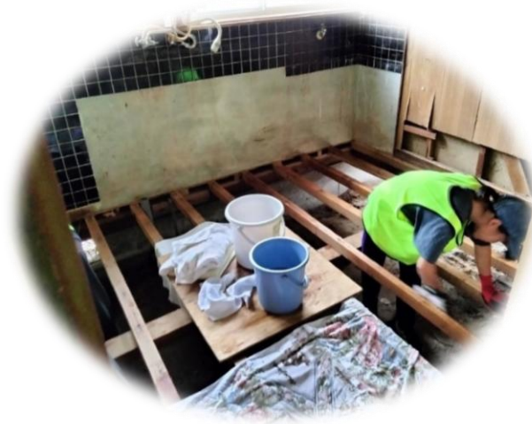
津波を被った家屋の泥はがし (石川県珠洲市)
