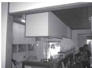
防災垂れ壁設置
