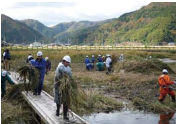
湿地内に生い茂る草の除去作業
